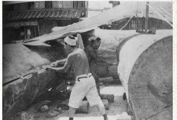
木挽職による作業光景 おが大鋸という道具で製材する
