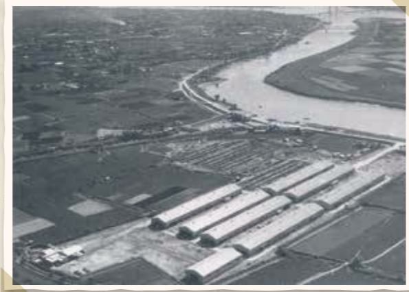
【昭和42年】建設中の大川家具工業団地。(三又地区家具工業団地)
