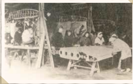
木製飛行機の主翼の組み立て
